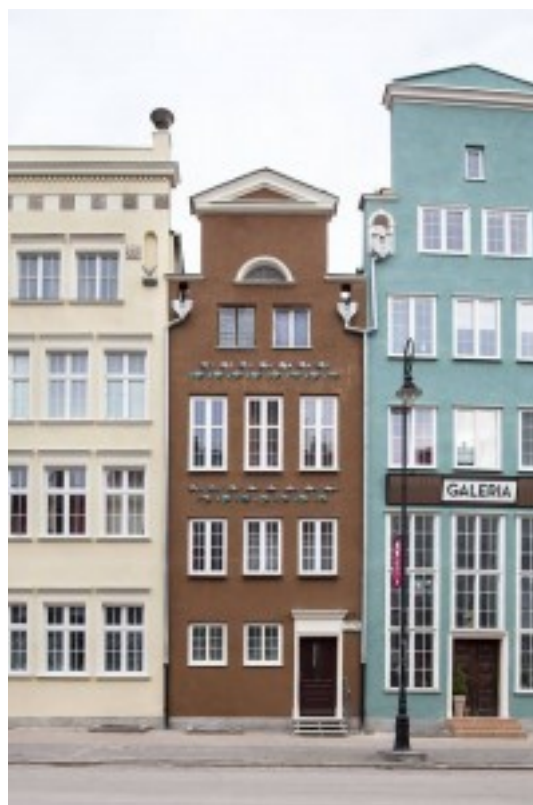
Fot. 14. Kamienne, ceramiczne i metalowe detale na zrewitalizowanych fasadach modernistycznych kamienic przy ul. Szerokiej w Gdańsku, 2014, fot. Fundacja Urban Forms.
