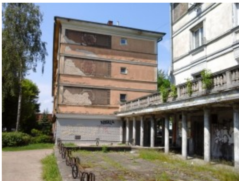
Fot. 7. Domy osiedla staromiejskiego przy ul. Podrzecznej 2/4 i 6/12, fot. W. Kazimierska-Jerzyk, maj 2015.
