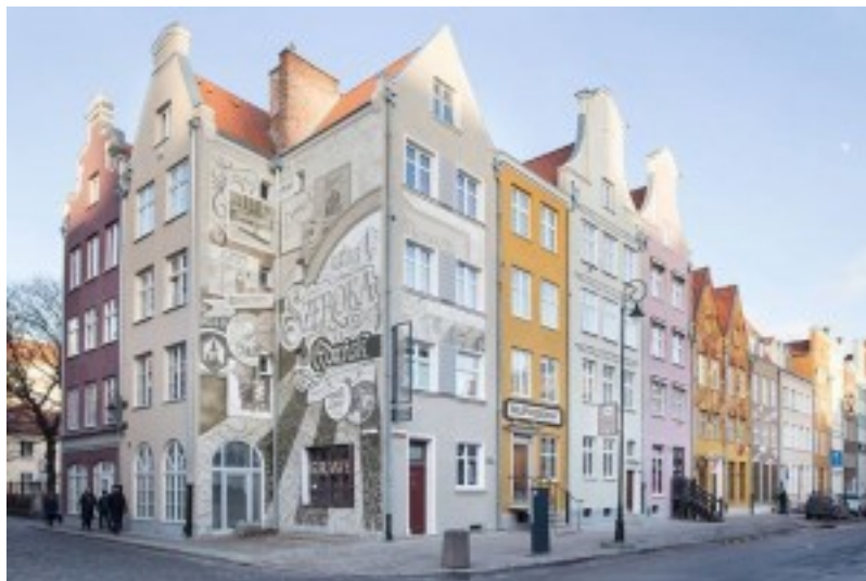
Fot. 13. Zrewitalizowane fasady modernistycznych kamienic przy ul. Szerokiej w Gdańsku, 2014, fot. Fundacja Urban Forms.
